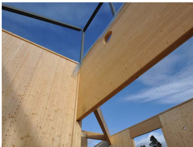
Stokmarknes ungdomsskole, under bygging i massivtre med løsning for fornybar energi. Står ferdig til skolestart i 2020. Foto: Stein Petter Hillestad.
